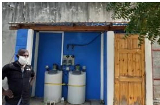
Fotos 1 & 2.- Nuevo CTE e Instalación Cloro en Aquin
