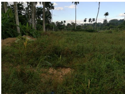
Fotografía 11: Excavación humedales Prosperidad
