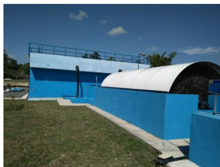
Fotografía 4: PTAR Mantilla Biodisco y digester San Matías
