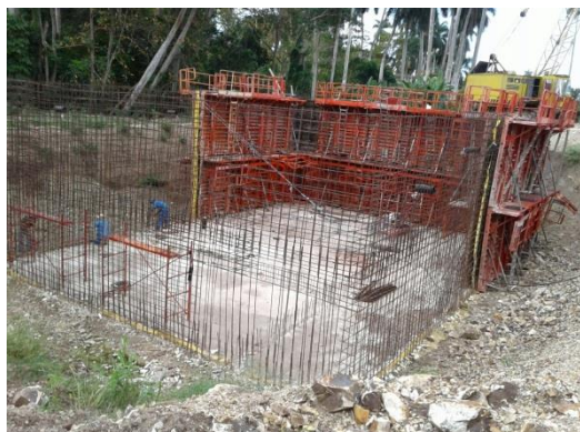
Fotografía 9: Excavación foso bloque de tratamiento de Prosperidad
