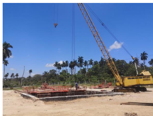
Fotografía 10: Excavación foso bloque de tratamiento de Prosperidad
