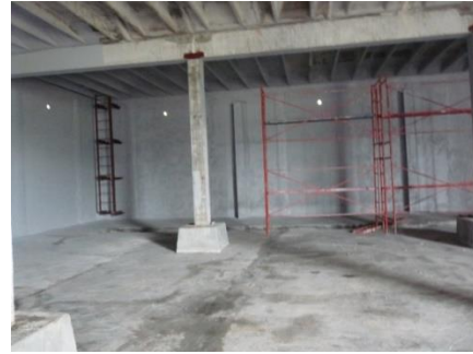
Fotografía 2: Impermeabilización Tanque de La Mañoca Guisa
