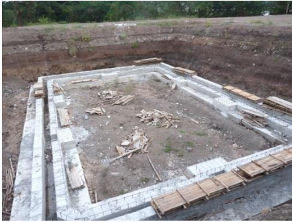
Fotografía 1: cimentación depósito PTAP Guisa
